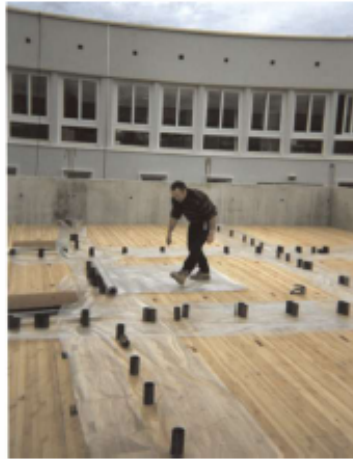
Une solution de renforcement: le plancher mixte bois-béton.
